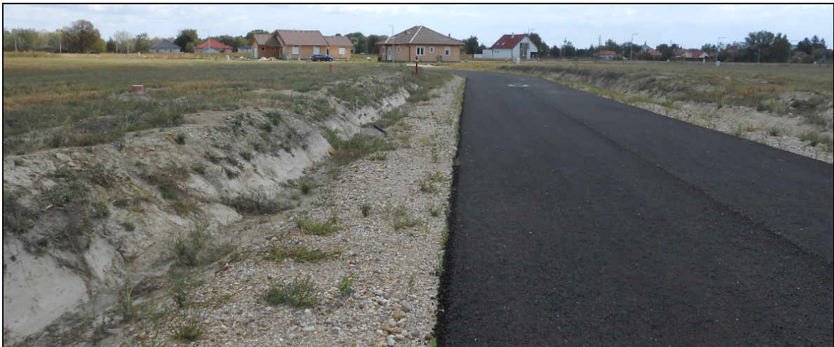
Csapadékvíz elvezető árok készítése a nagyréti lakóterület 1. ütemű beépítési területén /Fotó: Regioplan Kft./
